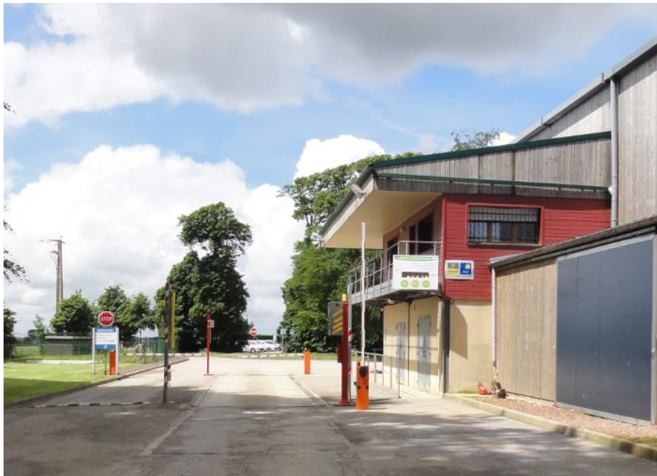
Figure 5 : Pont-bascule et détection de la radioactivité à l'entrée du site (Source : Visite BURGEAP du 10/06/2016)
