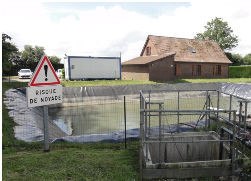
Figure 2 : Balisage des bassins, ici sur bassin incendie BI (Source : Visite BURGEAP du 10/06/2016)
